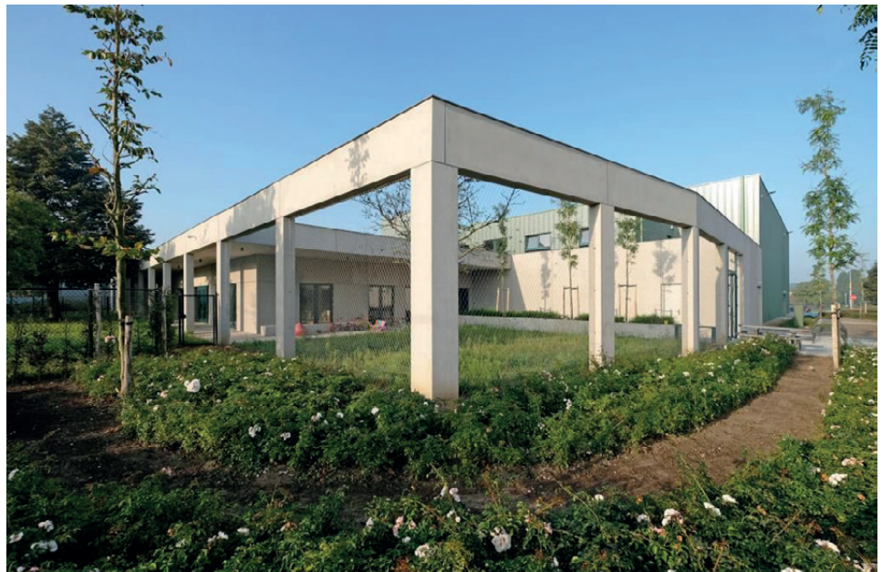
Betonnen portieken omhelsen de buitenruimte en maken het gebouw tot één geheel.
