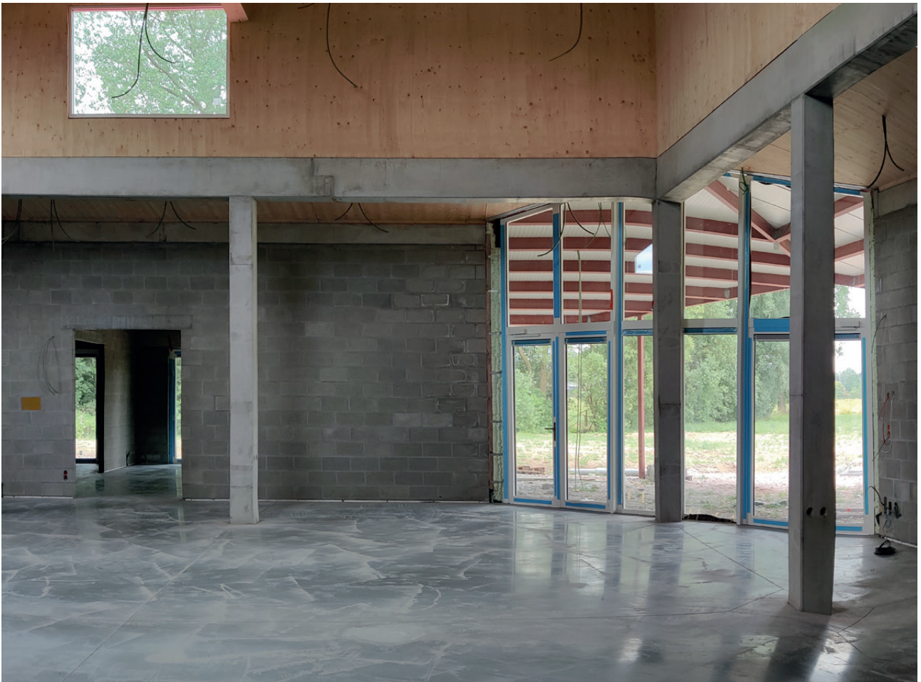
Ruime jeugdlokalen schakelen zich rondom het dubbelhoge atrium.
