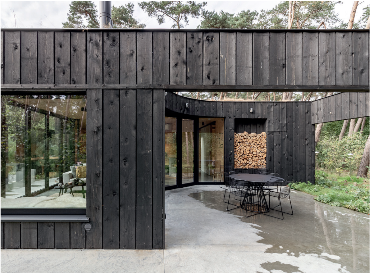
De duurzame CLT-constructie wordt afgedekt met zwart gebrand hout.
