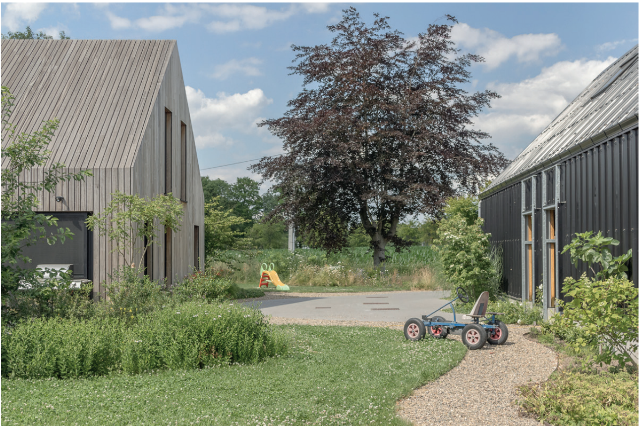
Door een organische tuinaanleg tussen de gebouwen ontstaan aangename, beschutte buitenplekken in de Loenhoutse velden.
