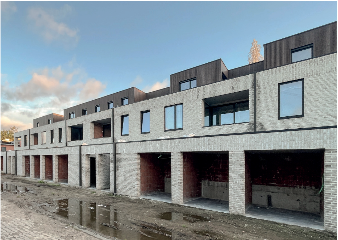
Achterliggende tuinbergingen met groendak beëindigen het gebouw achteraan. Trapsgewijs wordt het gebouw in enkele stappen opgebouwd.
